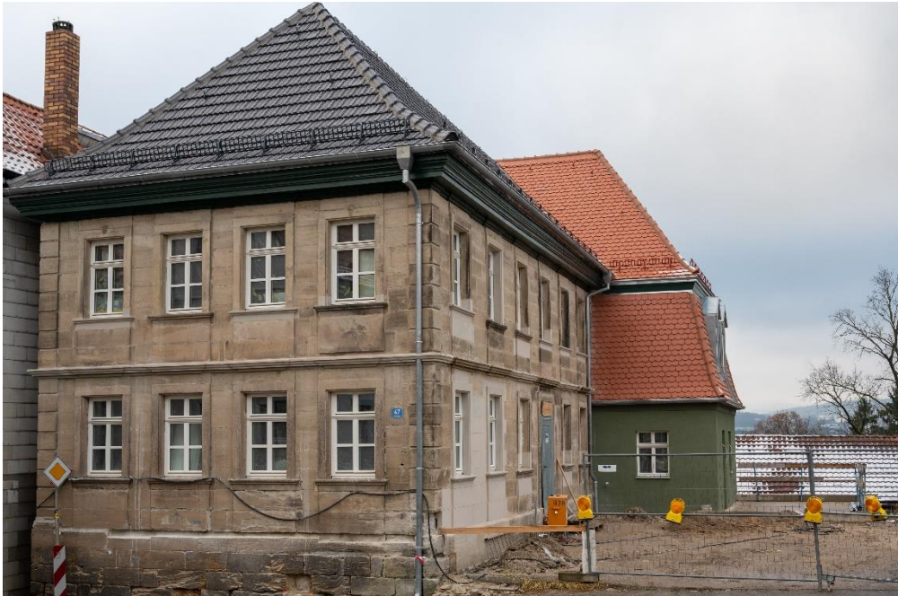
Am Flecken 47 entsteht der Dorfladen. Hier soll man „kaafn und waafn“ können
