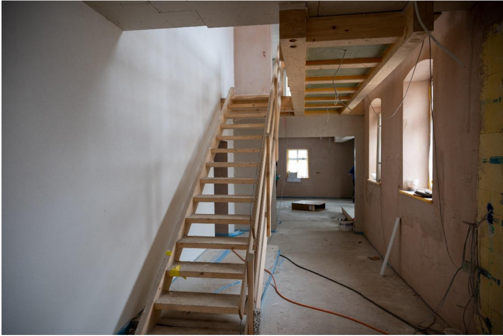
Der Eingangsbereich mit dem Aufgang zum Obergeschoß
