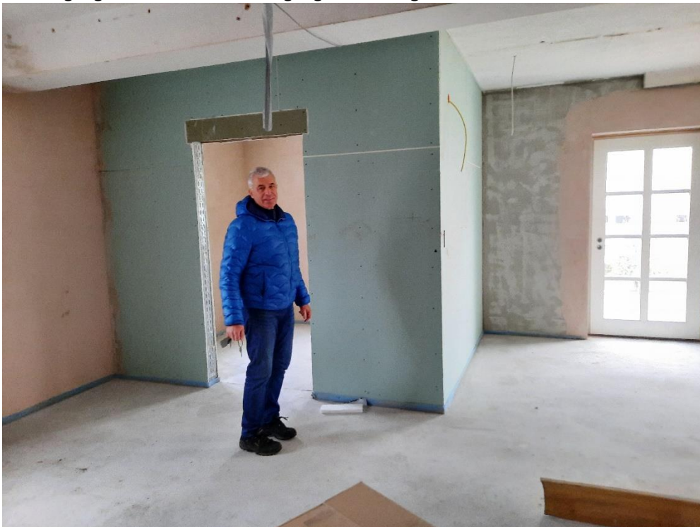
Der Bauerr, 1. Bürgermeister Gregor Friedlein-Zech, informiert sich über den Baufortschritt, hier im Bereich des Cafés
